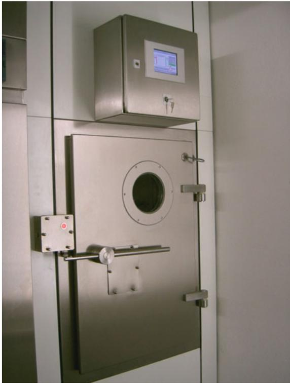
**Abb. 13** Ansicht Durchreicheschleuse (Fa. HT Labor + Hospitaltechnik AG)
