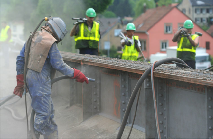
Abb. 2 Beim Sandstrahlen von Brücken und anderen Stahlkonstruktionen handelt es sich um eine physisch extrem fordernde Tätigkeit. Ein Roboter (z. B. von Sabre Autonomous Solutions) kann dem Menschen diese belastenden Tätigkeiten abnehmen. Quelle: herreneck/Fotolia.com
