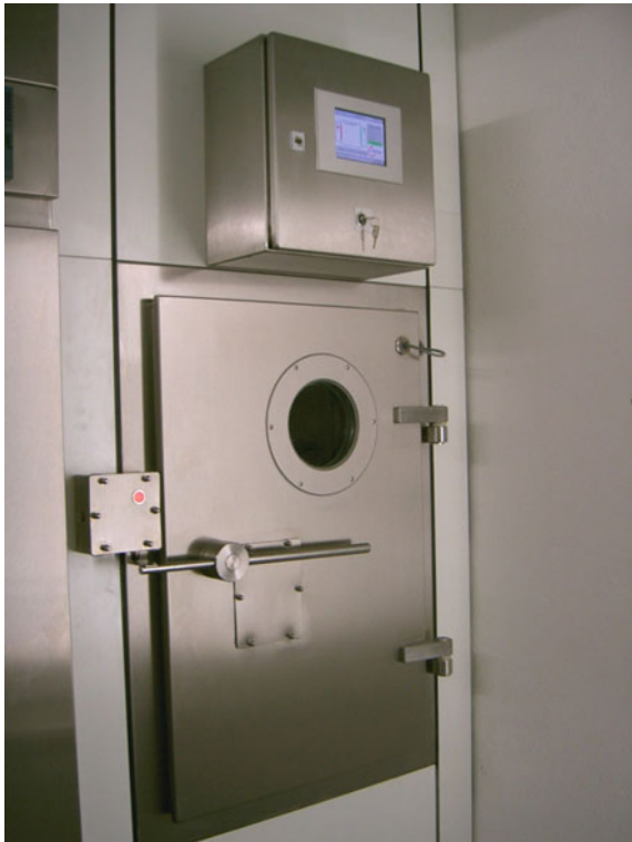
Abb. 13 Ansicht Durchreicheschleuse (Fa. HT Labor + Hospitaltechnik AG)
