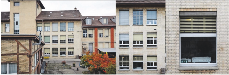
Abbildung 8: Fassadenausschnitt Gebäude LP 190
