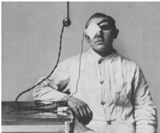
Abb. 15. Elektrischer Augenwärmer mit Schnurrheostat.
